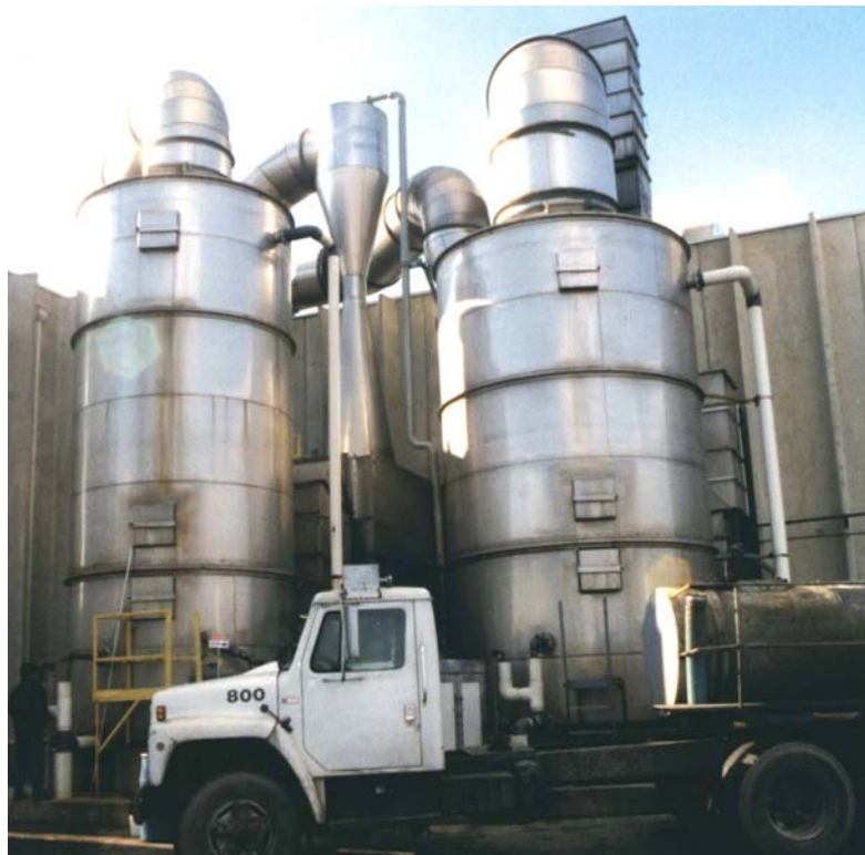
Ein Venturi-Wäscher mit zwei Waschkolonnen in Kombination
